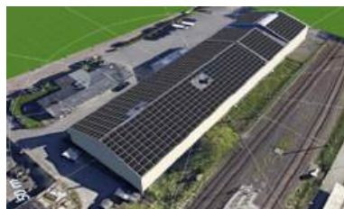
Niedersachsen voraussichtlich 296 kWp
