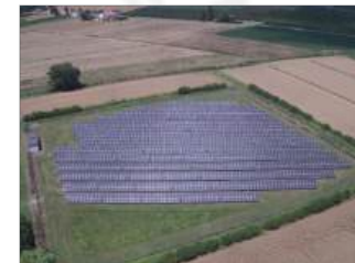
Italien Freifläche in Betrieb 500 kWp
