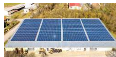
PVA Heldburg 193 kWp Prognose: 938,05 kWh/kWp Ø der letzten 4 Jahre: 1017,14 kWh/kWp
