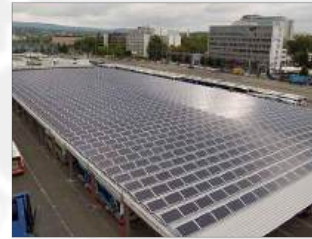
Deutschland Abbau Anlage 405 kWp
