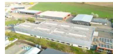
PVA Bad Lippspringe 162 kWp Prognose: 966,96 kWh/kWp Ø der letzten 4 Jahre: 1092,63 kWh/kWp
