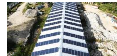
PVA Lohmen II 96 kWp Prognose: 935,57 kWh/kWp Ø der letzten 4 Jahre: 1015,69 kWh/kWp
