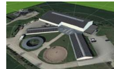
Schleswig-Holstein voraussichtlich 264 kWp
