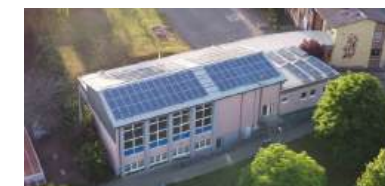
PVA Ballweiler 35 kWp Prognose: 916,2 kWh/kWp Ø der letzten 4 Jahre: 950,5 kWh/kWp
