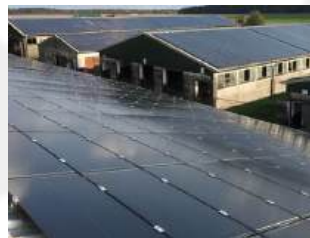
Deutschland Dachanlage in Betrieb 580 kWp
